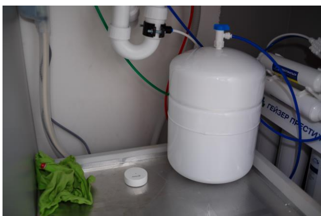
Рисунок 19: Варианты установки датчиков протечки и движения
