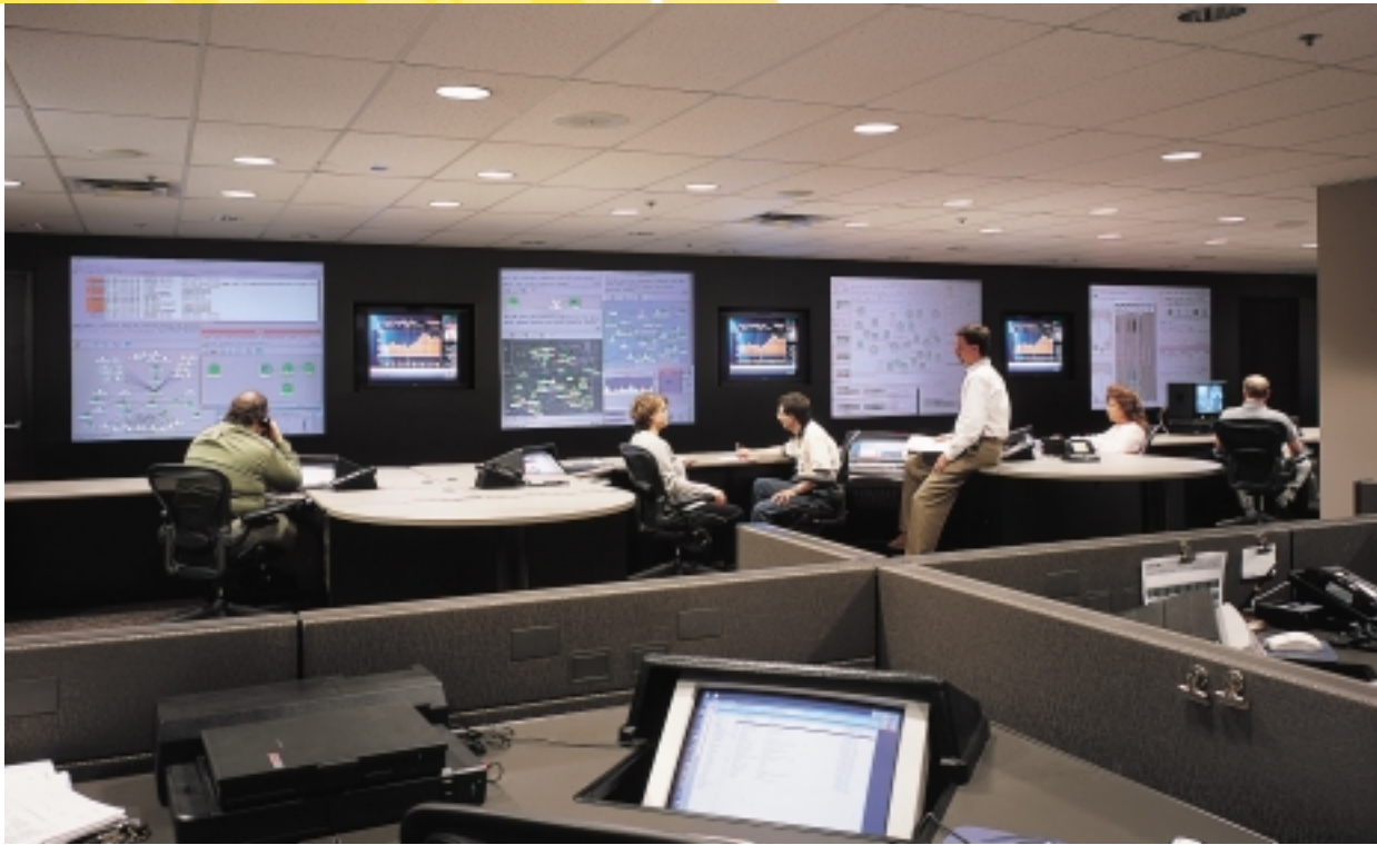
Центр управления работой сети. Установлено компанией NOR-COM. Проект включает в себя четыре экрана IRUS размером 56" x 74" каждый.
